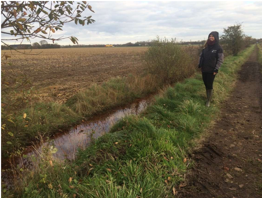
Foto fra besigtigelsen af den relevante strækning; Mette Brandt Mouridsen markerer den opstrøms kant af det fire lange betondæk.
